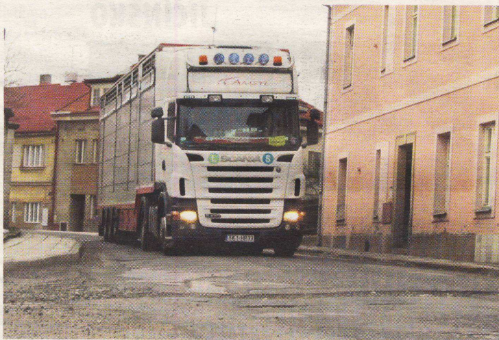
Průtah Miletiínem je samá díra. Projekt na opravu údajně existuje dvacet let. FOTO | TOMÁŠ HEJTMÁNEK
